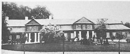
617. Woronicza. Elewacja frontowa dworu, przed 1914 r.
