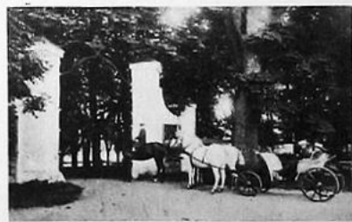
613. Woronczka. Brama wjazdowa od strony dziedzicznej, przed 1914 r.
